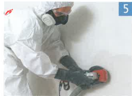
5 Schimmelbeseitigung ist keine Arbeit für den Laien. Hier wird fachgerecht abgeschliffen.
