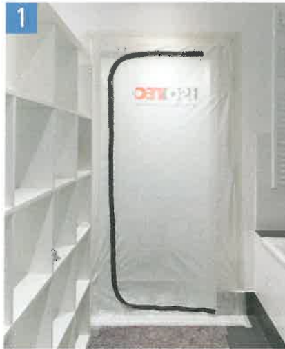
1 Mit einer Schleuse wird verhindert, dass sich die Schimmel-Sporen im ganzen Haus verteilen.
