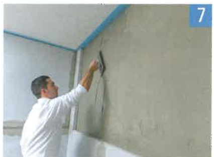
7 Die Profis bringen die Kombiflexabdichtung in zwei Arbeitsgängen nacheinander auf.
