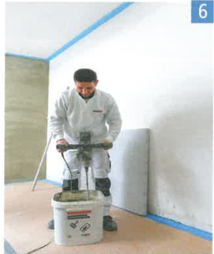
6 Die Kombiflexabdichtung wird angemischt. Sie bildet die eigentliche Abdichtungsebene.
